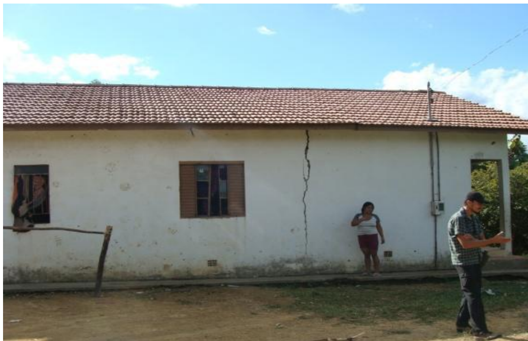
Figura 11: Rachadura na casa provocada pela instabilidade do solo
